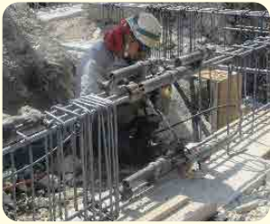
基礎工事の様子
