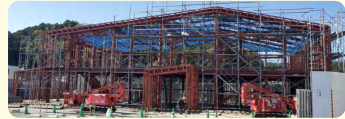
鉄骨工事の現場写真
